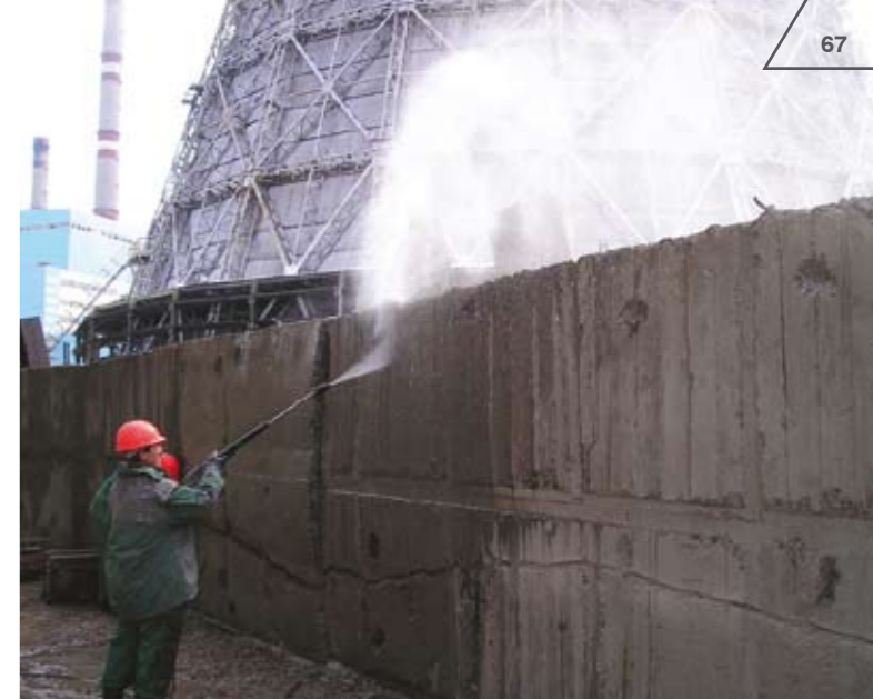
Prieš padengiant hidroizoliacija betoninis paviršius prisodrinamas vandeniu hidromonitoriaus pagalba
