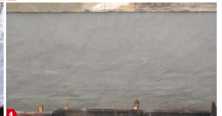
Hidroizoliacinis tinkas KALMATRON ant paviršiaus užnešamas įprastiniu tinkavimo būdu. Priklausomai nuo konstrukcijų glotnumo ar suirimo laipsnio rekomenduojama remontuojamus paviršius tinkuoti 1,5–2 mm hidroizoliacinio mišinio sluoksniu
