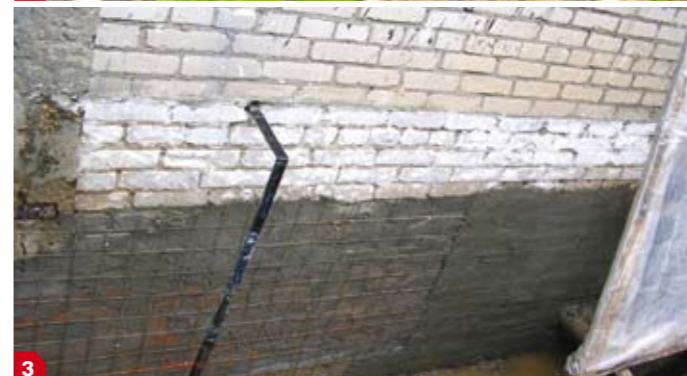
Hidroizoliacinis tinkas KALMATRON ant paviršiaus užnešamas įprastiniu tinkavimo būdu. Priklausomai nuo konstrukcijų glotnumo ar suirimo laipsnio rekomenduojama remontuojamus paviršius tinkuoti 1,5–2 mm hidroizoliacinio mišinio sluoksniu
