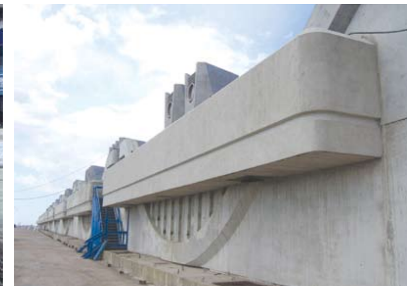
Apsaugos kompleksas nuo potvynių Sankt Peterburge
